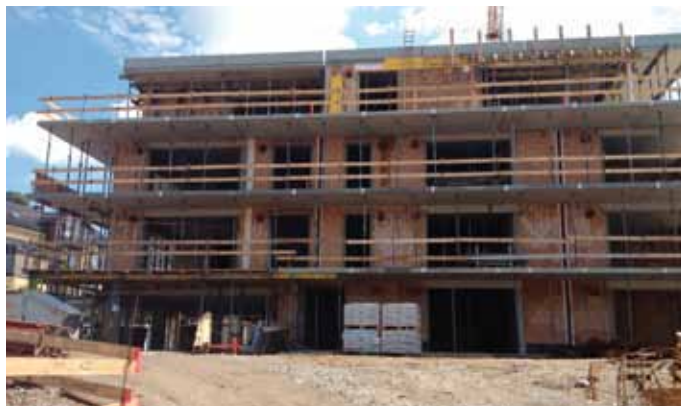
Od hrubé stavby ...
