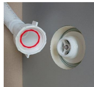
Vložte těsnění do převlečné matice, která je součástí flexi připojení
