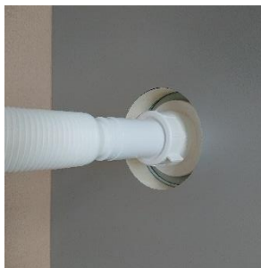
Našroubujete flexi připojení na výpust
